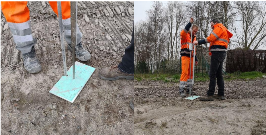
Figuur 11.5-1 – voorbeeld slagsondeproef
