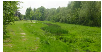
Systeem van grachten en wadi's voor opvang hemelwater
